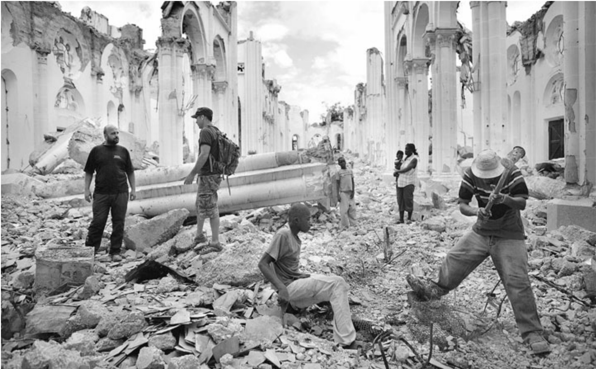
Nur noch Ruinen: Auch die Kathedrale von Port-au-Prince wurde bei dem Beben zerstört. Einige Haitianer suchen hier nach Baustahl, um ihn zu verkaufen.
